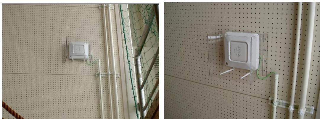
図 5-19 無線アクセスポイントのパネルによる保護状況
