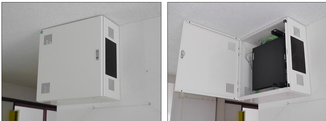
図 5-3 フロアスイッチとHUBボックス
