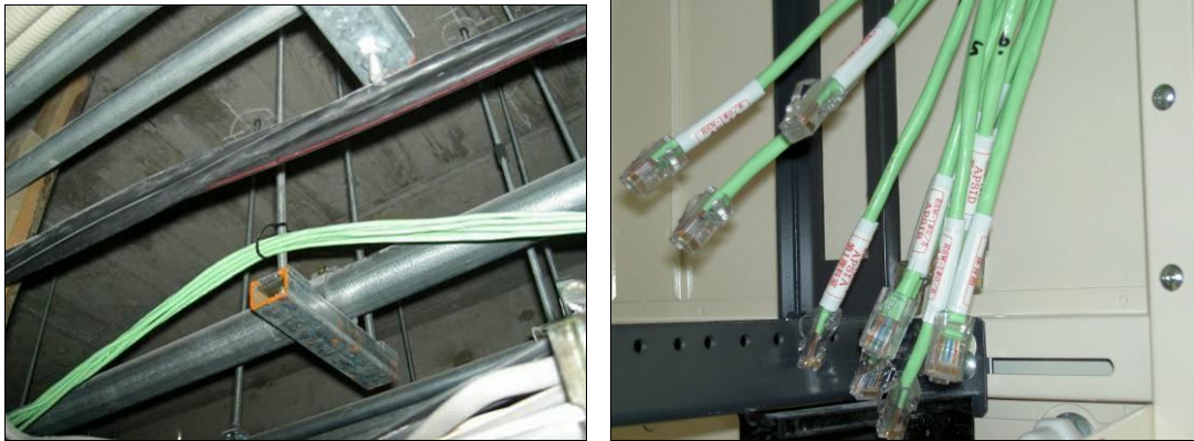
図 5-1 天井配線状況と両端のケーブルタグ
