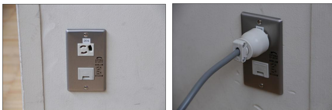
図 4-2 教室内電源コンセントの増設
