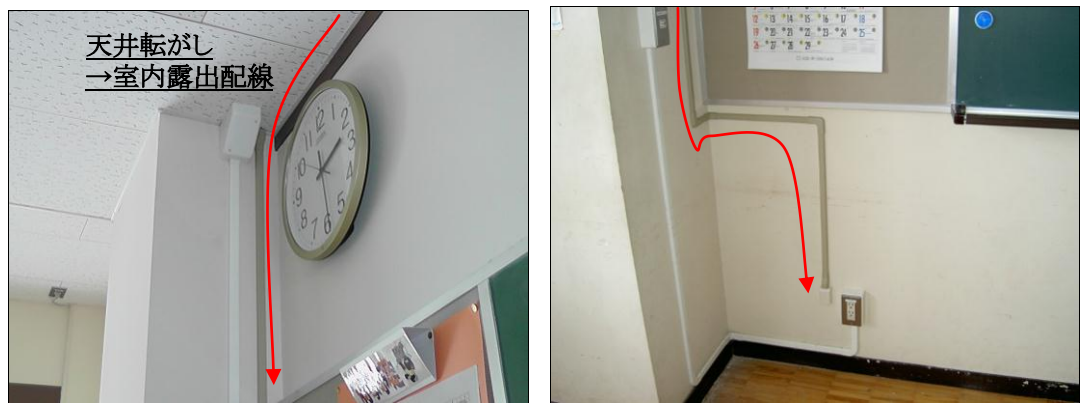
図 5-2 教室内配線設備(モール保護)
