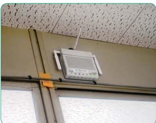
(参考) 教室天井近くの壁に無線LANアクセスポイントを設置した例
