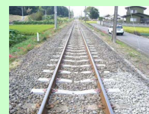
【木マクラギのPCマクラギ化】
