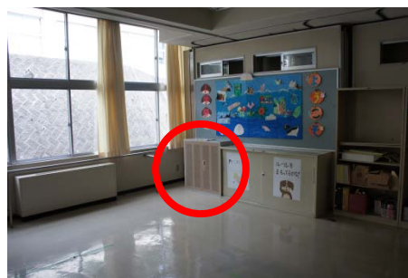
共有スペースへ配置した 充電保管庫の例
