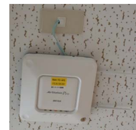
LANケーブルから給電できる PoEハブから電源供給を受けている 無線LANアクセスポイント
