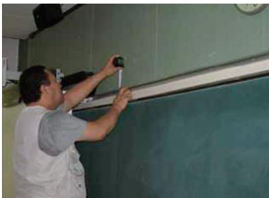
上レールの水平を調整している様子
