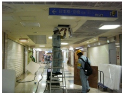
深夜作業による施工
