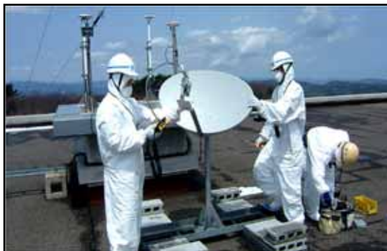
福島第一原子力発電所事故に伴う 避難指示区域内での工事
