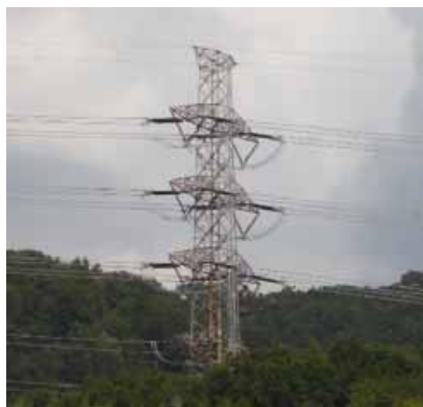
山間部での送電線保守 (アナログ60MHz 150MHz移動無線)
