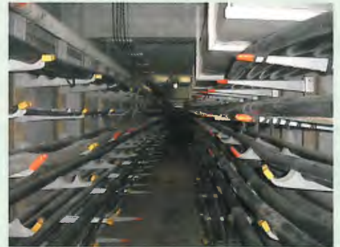
とう道(NTTケーブル専用の地下トンネル)
