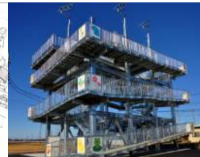
津波避難タワー 「きらりんタワー」
