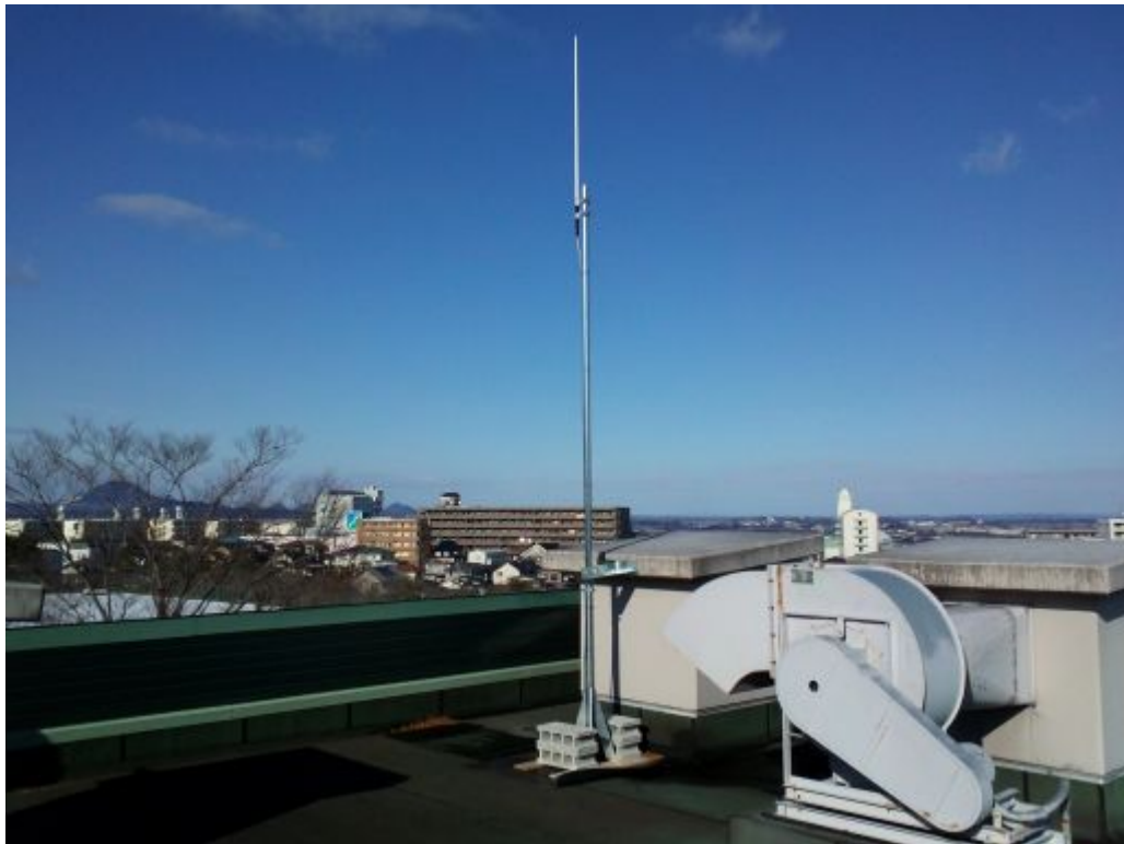
親局アンテナ設置状況（高齢者福祉施設「屋上」）
