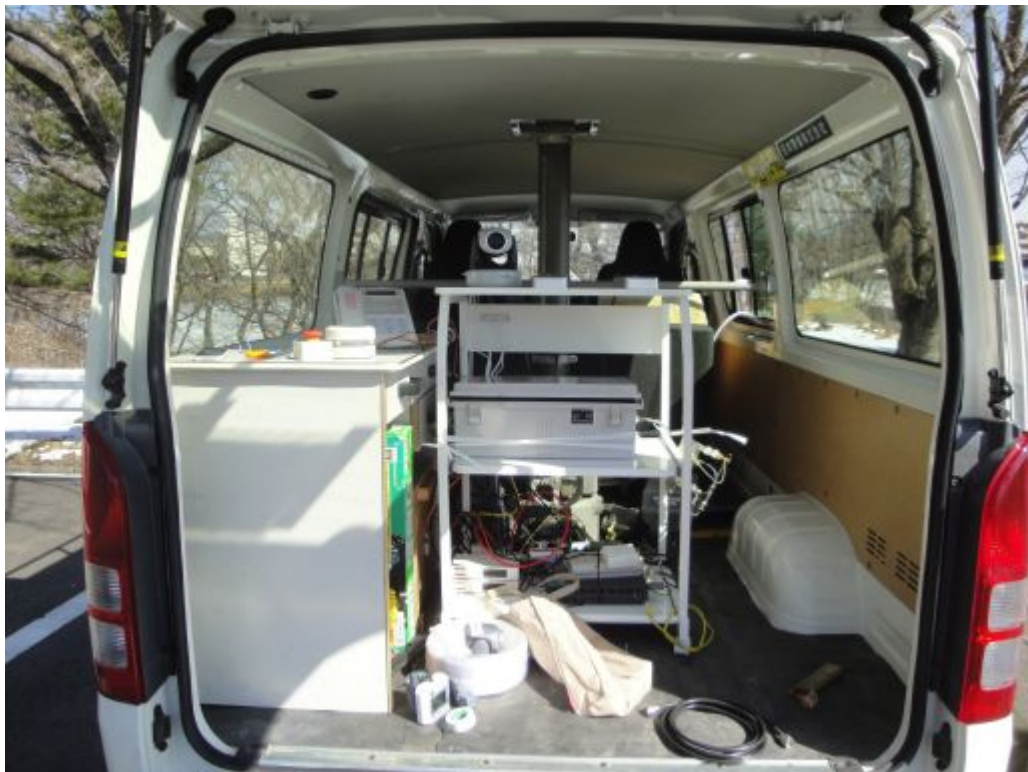
子局用機器設置状況（通信確認地点 1）
