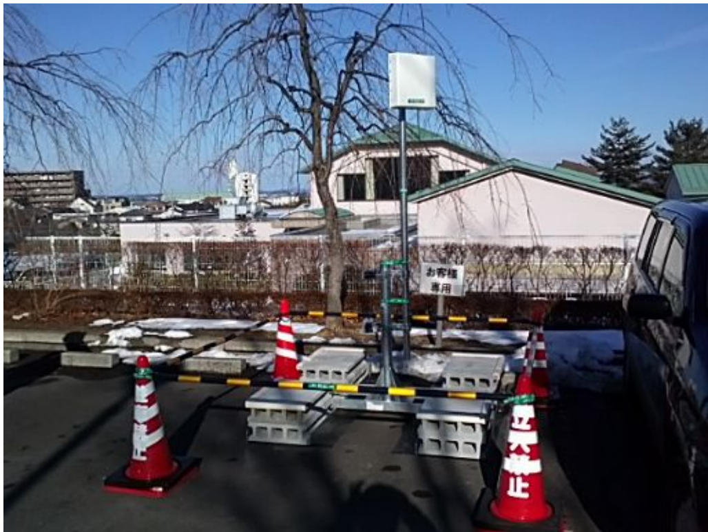
エリアワンセグ装置設置状況（高齢者福祉施設「駐車場」）
