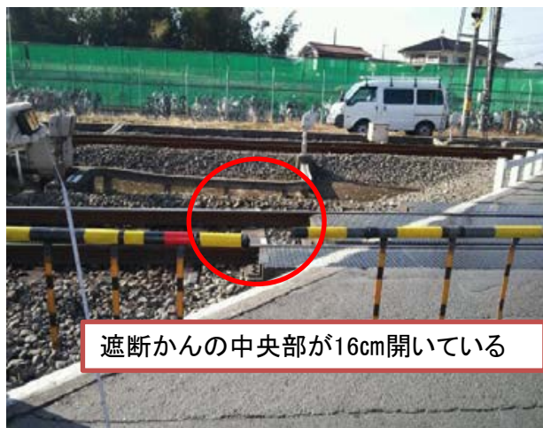
遮断かんの調整により遮断の状態が改善された例
