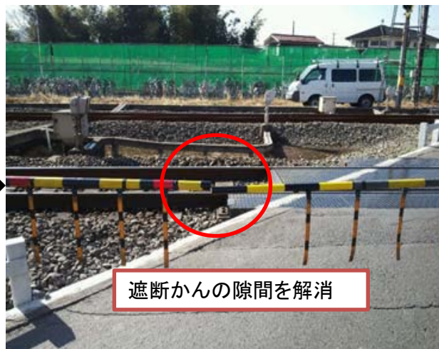
遮断かんの調整により遮断の状態が改善された例
