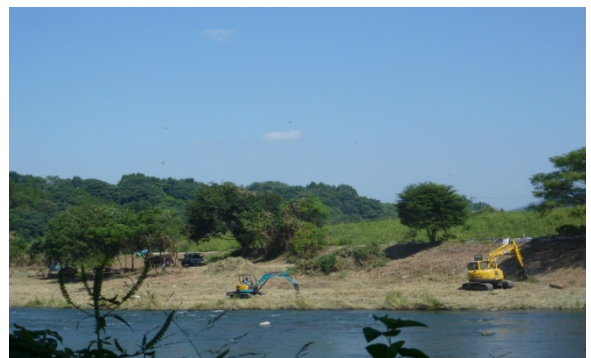
【着工中の写真】
