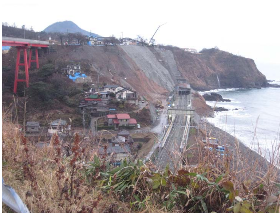
写真 2.1 中越沖地震により崖崩れが発生したJR信越本線青海川駅付近の復旧工事
