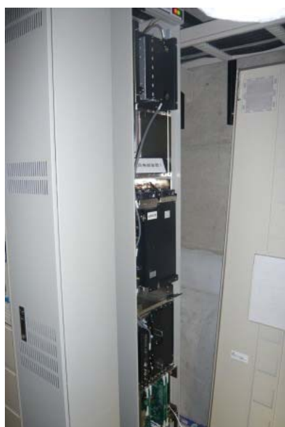
写真3.9 基地局無線装置1 (EL-CELP、疑似S方式)
