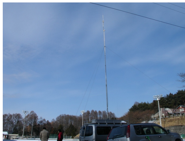
写真 3.19 無指向性アンテナ設置時
