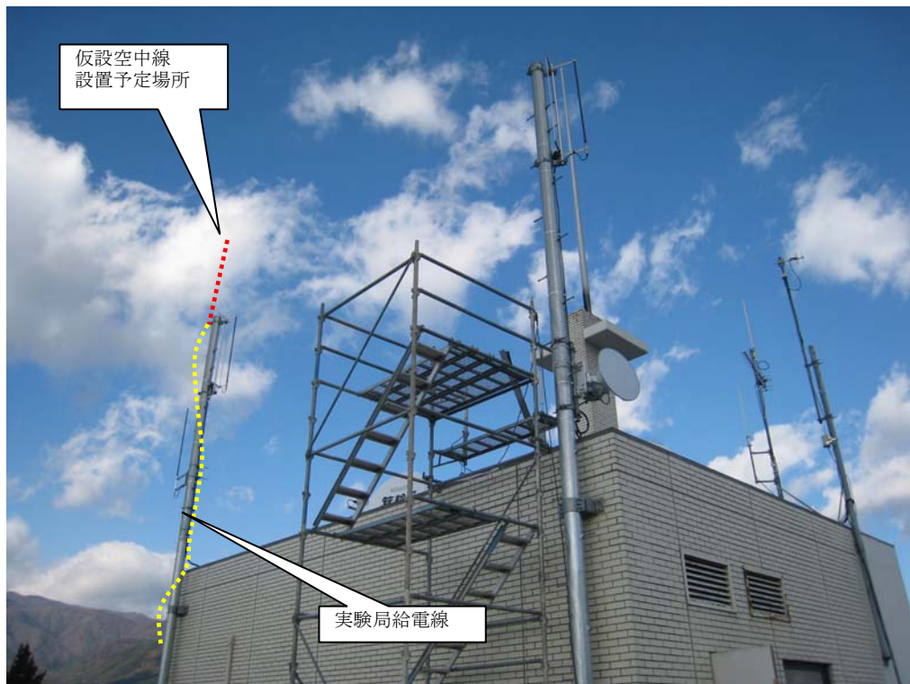
庁舎屋上実験局アンテナ仮設予定場所 (空中線柱最上段に仮設固定する。空中線は無指向アンテナ)
