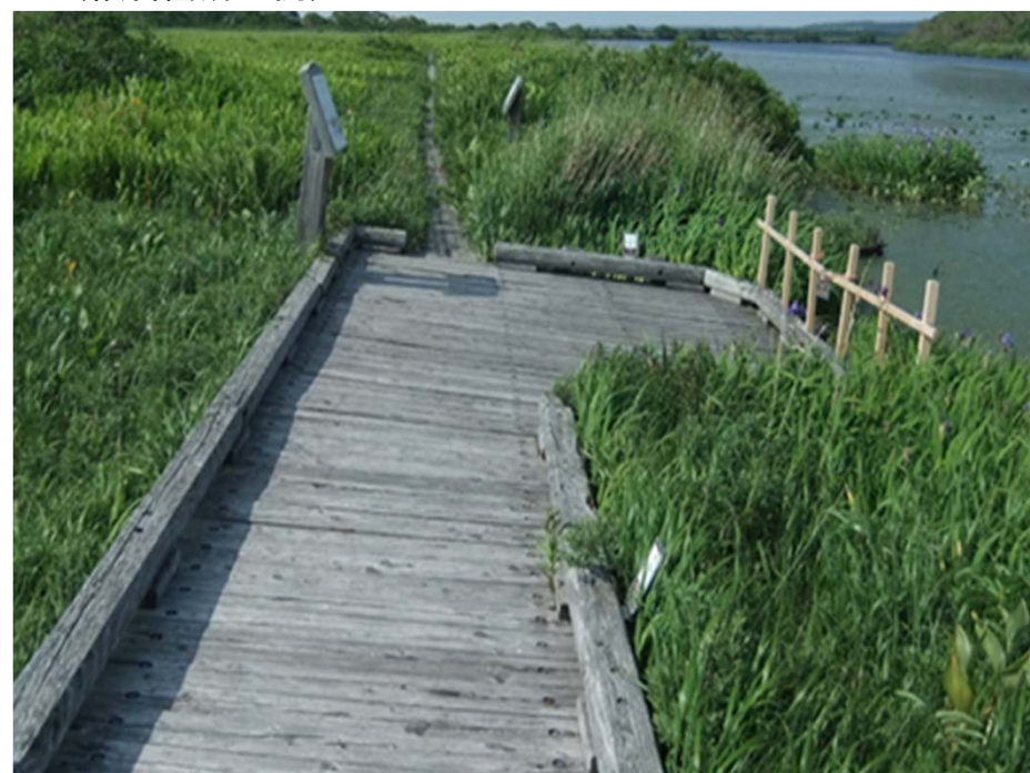
〈傾斜箇所の例〉
