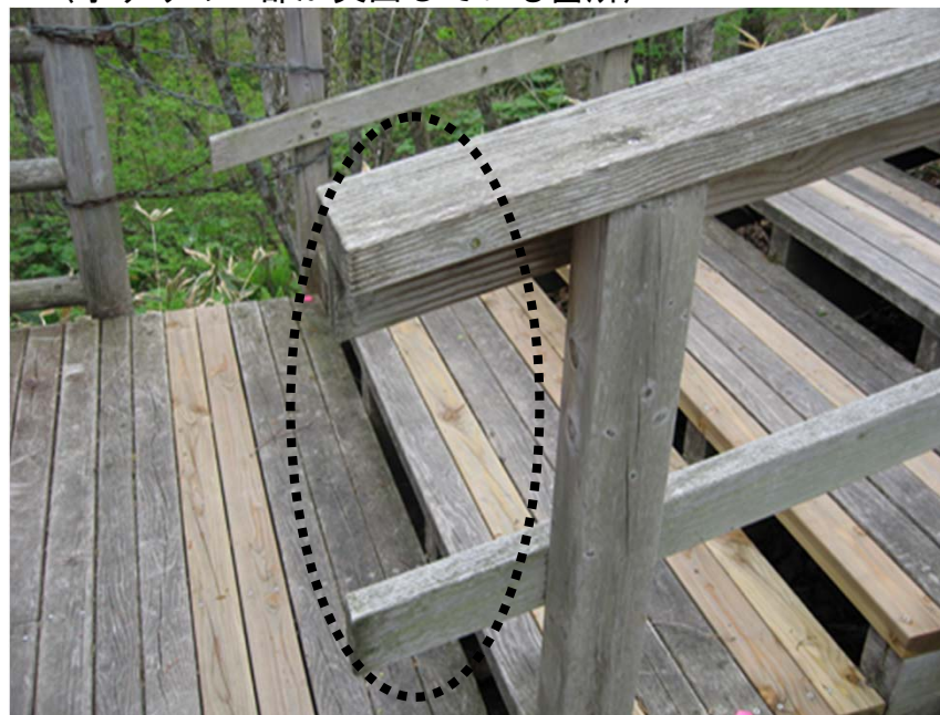
〈手すりの一部が突出している箇所〉
