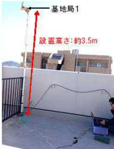
基地局 1 の設置状態
