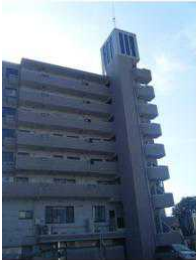
基地局 1 を設置した小林ビル
