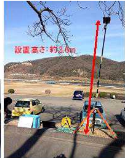
基地局 2 の設置状態
