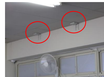
写真2: 教室に2台 アクセスポイントを設置
