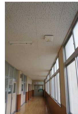
写真1: 廊下にアクセスポイントを設置した例
