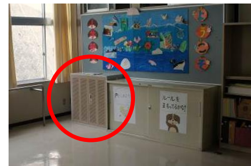
写真4: 児童生徒に配慮して充電保管庫を共有スペースに配置した例
