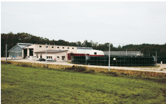
鹿追町環境保全センター
