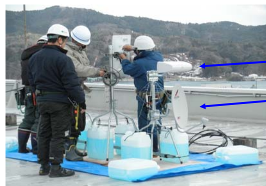
アンテナ組立設置
