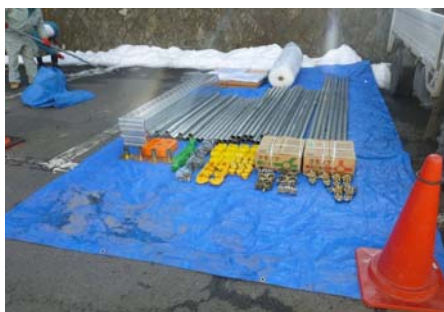
架台組立用部材 (ホームセンターで調達可能)
