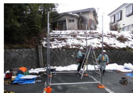
骨組み組立(約1時間)
