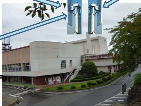
気仙沼市民会館屋上：基地局（AU）2系統 （標高50m）
