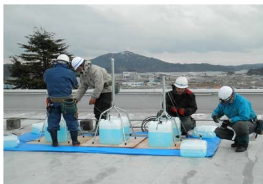
アンテナ架台組立
