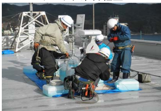
同軸ケーブル配線
