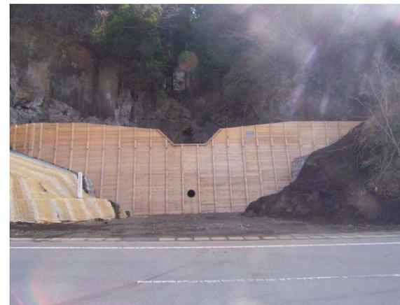
県産木材を使用した残置式型枠により築造した治山施設（産山村）<sup>48</sup>
