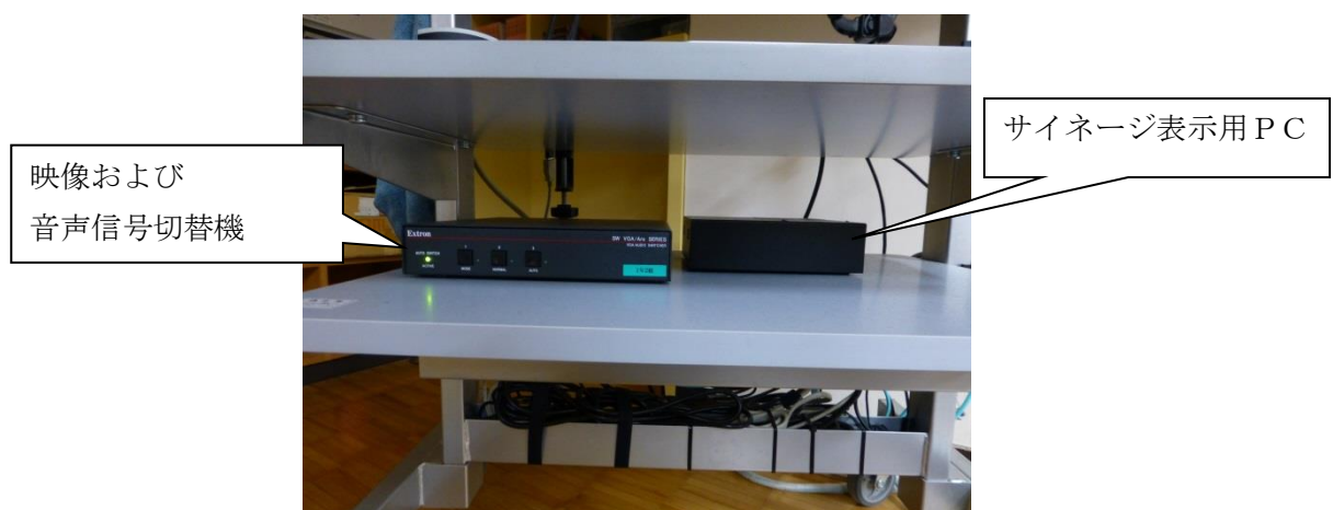
図 4. 4-2 設置した機器
