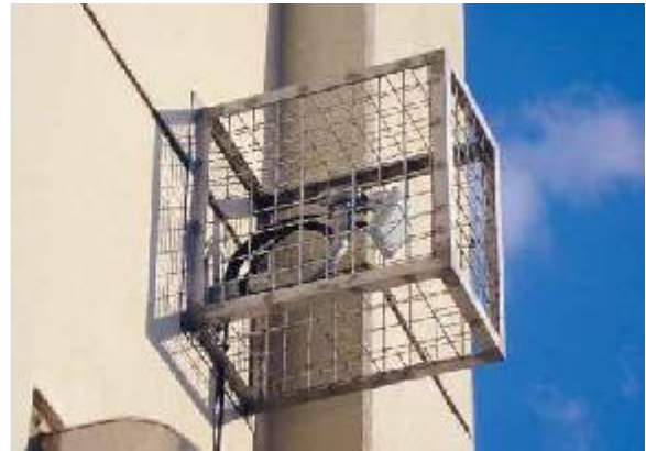
無線LANアンテナ（屋外）
