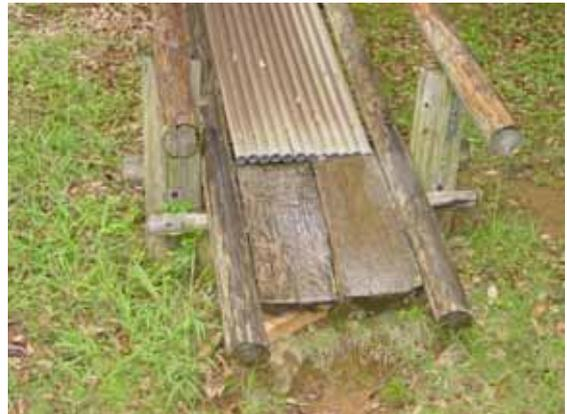
滑り台の先端部の板が脱落・跳ね上がる恐れがある
