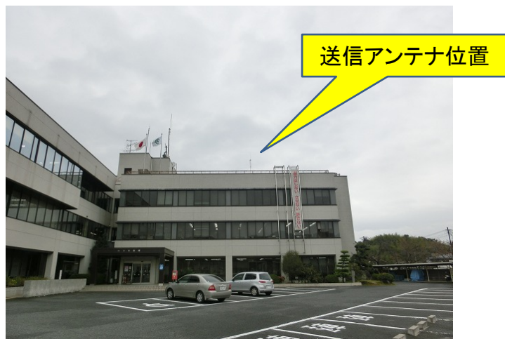
市役所屋上送信アンテナ
