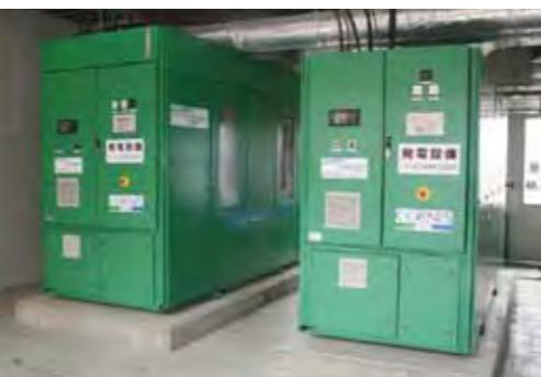
家畜ふん尿の処理過程で発生するバイオガスを燃焼し発電する。2台で300kwの能力で発電したエネルギーは施設内で利用し、余剰分は売電している。
