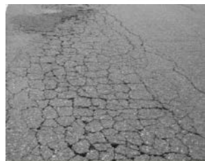
路面のクラックの抽出結果の一例
