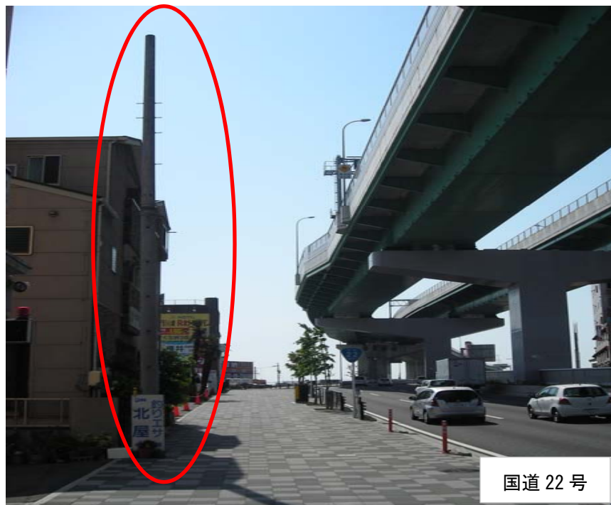
電柱が1本残っている
