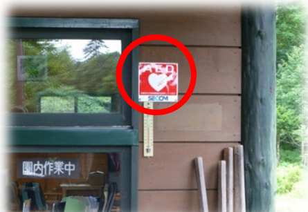
管理棟にAEDを設置している例
