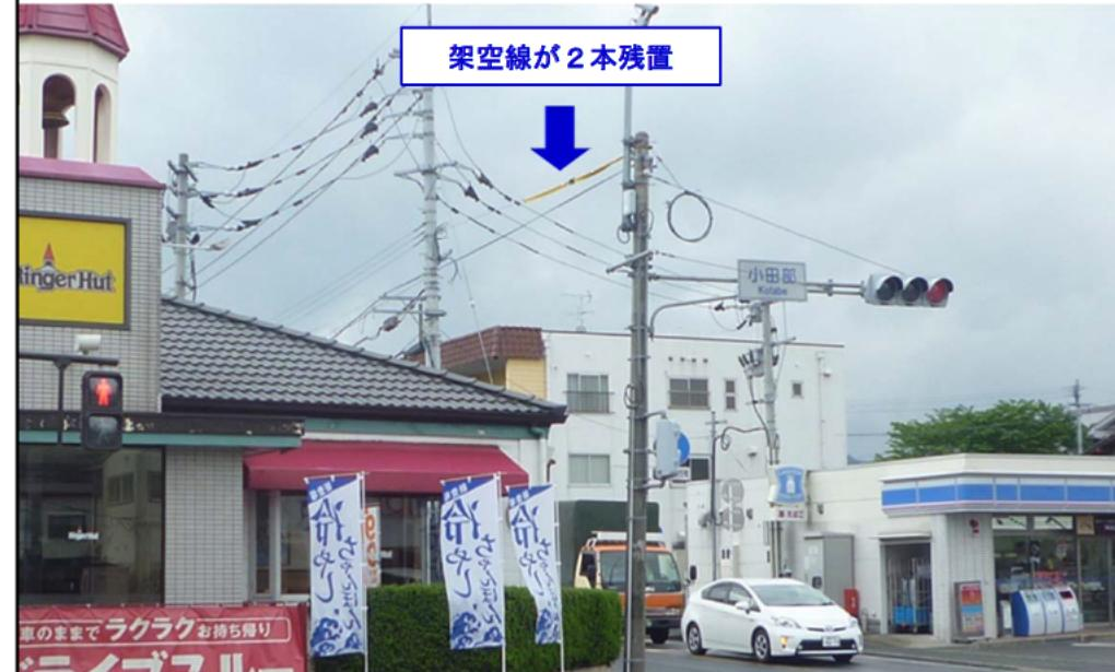
・残置している2本の架空線のうち1本の架空線は、電線管理者と信号機施工業者の間の連携不足のため、無電柱化区域内の信号機から同区域外の電柱の間に残置
