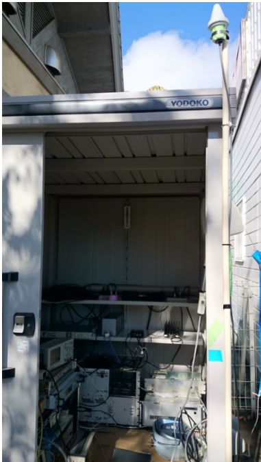
試験機材設置状況
