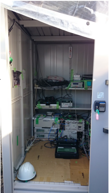
試験機材設置状況
