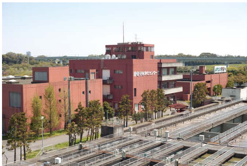
(守谷市浄化センター)
