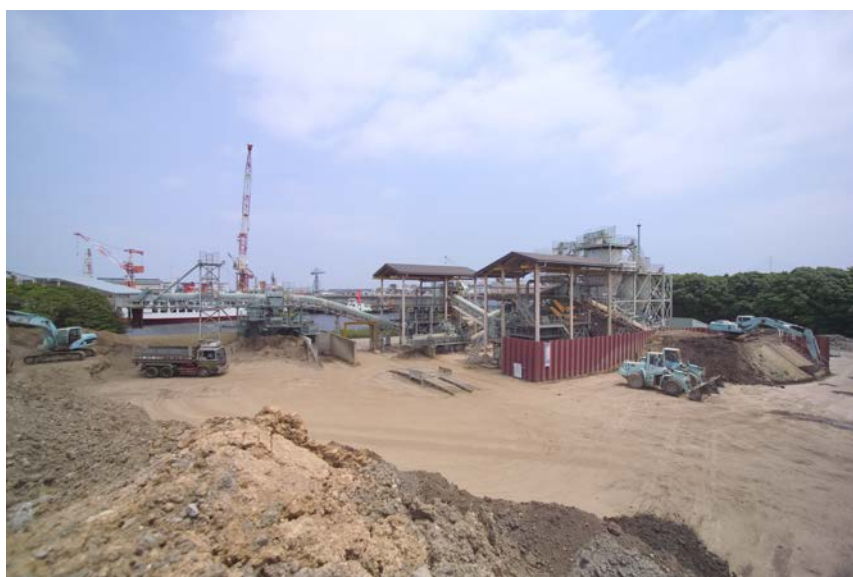
(横浜市環境創造局改良土プラント)
