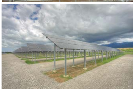
新潟東部太陽光発電所
