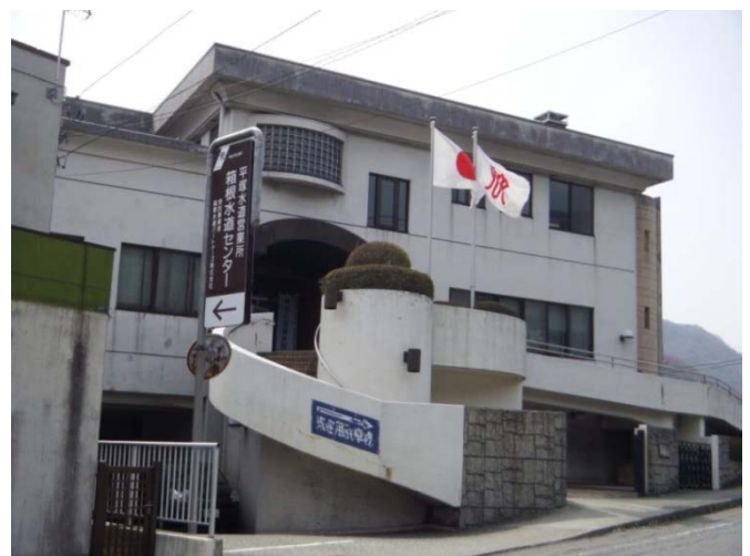
箱根水道センター
