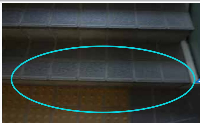
【小倉公共職業安定所庁舎】
