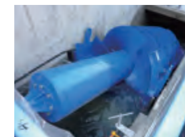
小水力市民発電所「元気くん3号」 少ない落差でもしっかり発電する、らせん式水車の「元気くん3号」。1号と3号には、溜まったゴミを除去する機能がついています。
