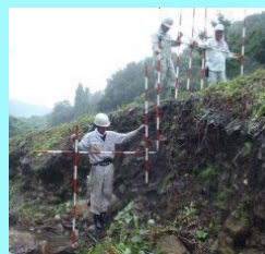
■被害確認調査
