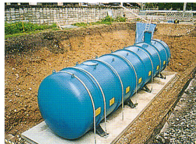
耐震性貯水槽
