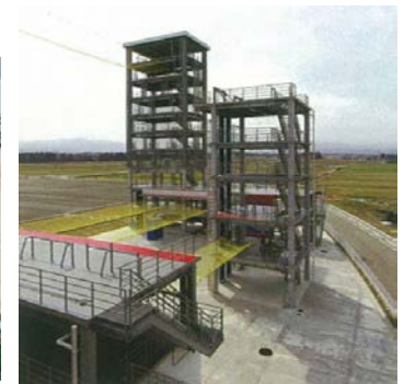
広域訓練拠点施設 (提供:富山県広域消防防災センター)
