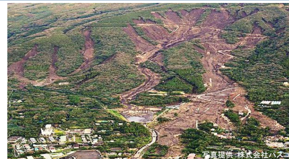
伊豆大島上空からの被害状況
