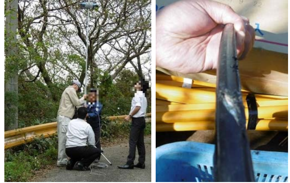
調査状況（左）と破損した設備（右）
