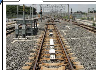
鉄道信号保安設備
