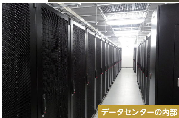
▶ データセンターの外観と センター内のサーバーラックの例
