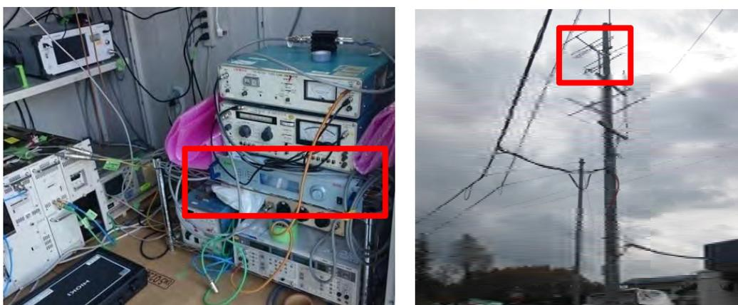
図 7.2-3 原村受信所の FM 送信機(左図の赤枠内)と FM 送信アンテナ(右図の枠内)
