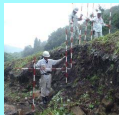
■被害確認調査
