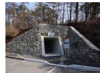
活動火山対策 避難施設
