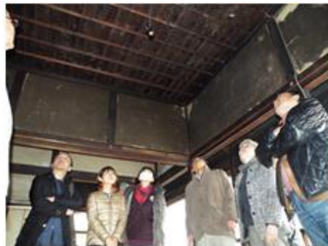
松亀園見学会 3階桜の間
