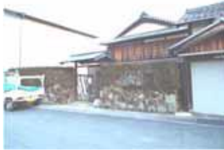
改修した古民家
