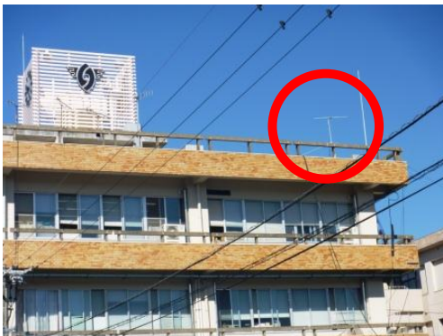
送信空中線遠景（八女市役所庁舎屋上）
