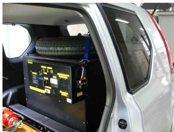
移動電源車の発電機操作盤
