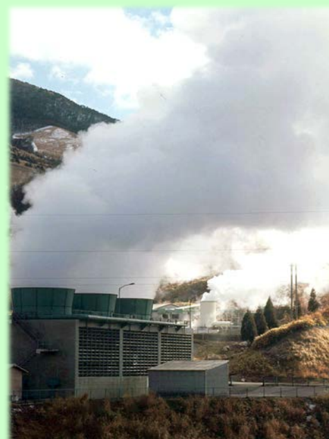
八丁原地熱発電所（九重町）
