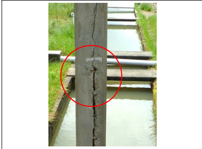
【犬鳴川・花の木用水樋管】
