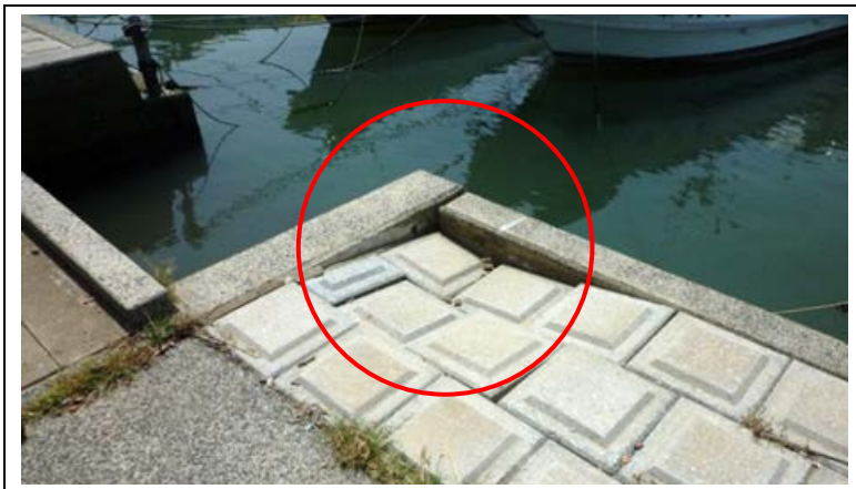
【西川・島津排水樋管】
