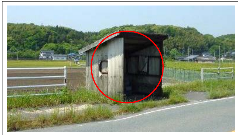
【英彦山川・堤防の川裏 (法面)】
