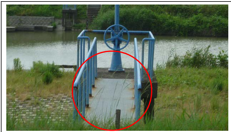
【穂波川・萩原用水樋管】
