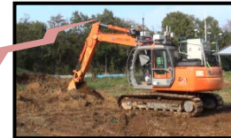
4K3Dカメラ搭載建設機械
