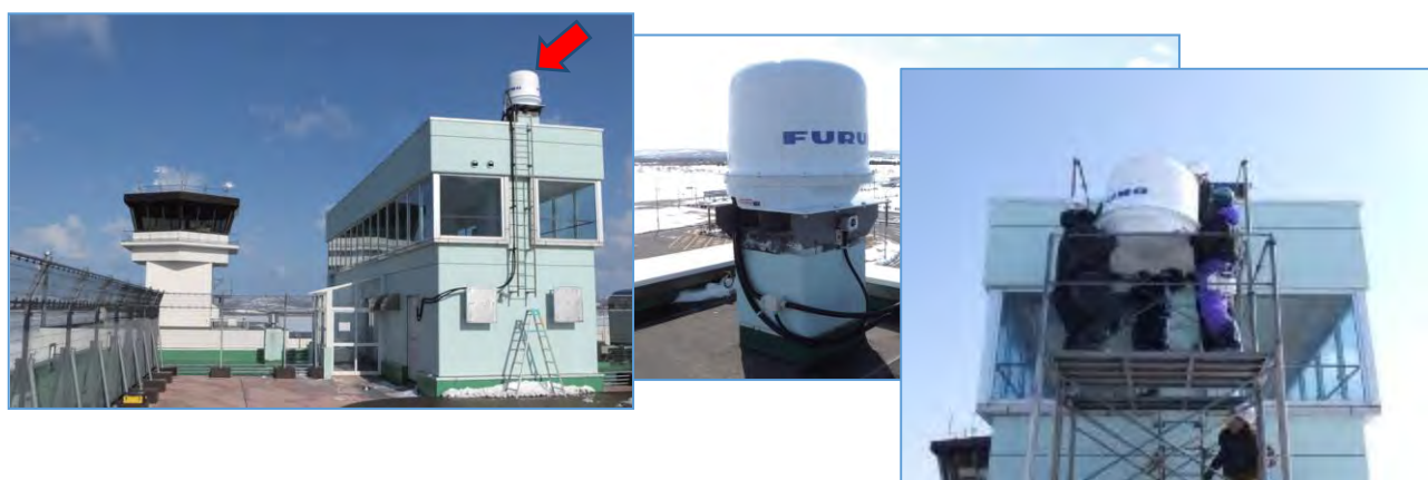
2.2-図 6 空港に設置した小型気象用レーダー
