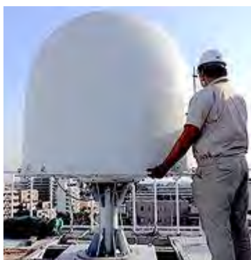
2.2-図 5 X 帯の小型気象用レーダー
